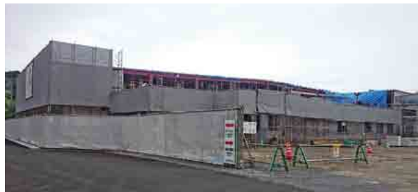
建設工事中の長崎工場
